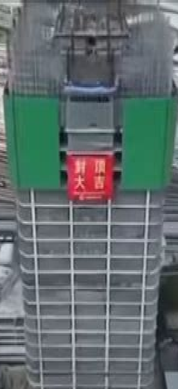
近日，由中铁十局承建的泰国审计局办公大楼项目主体封顶
